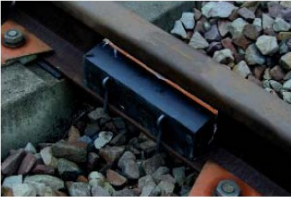
Exemples d'absorbeurs sur rail (Corus et Socitec)
