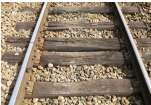
Rails courts sur traverses bois
