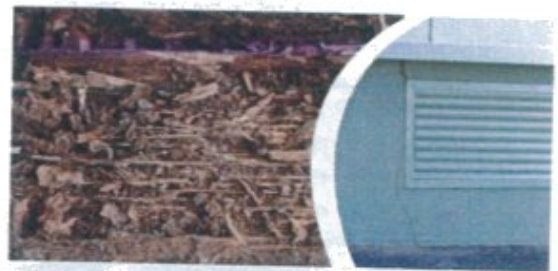
Cordon de termites en pied de construction
