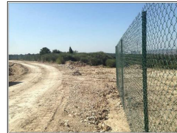
Figure 13 : Illustration d'une clôture d'une centrale photovoltaïque URBASOLAR (Source : URBA 127)
