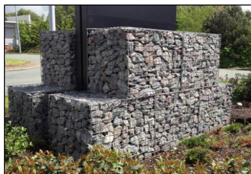
Figure 8 : Exemple de muret en gabion (Source : TCS Geotechnics)
