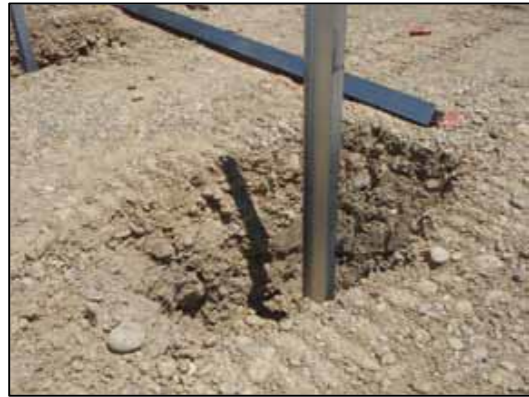
Figure 6 : Types de fondation - pieux battus (Source : Guide MEDDTL 2011 – NCA, 2015)
