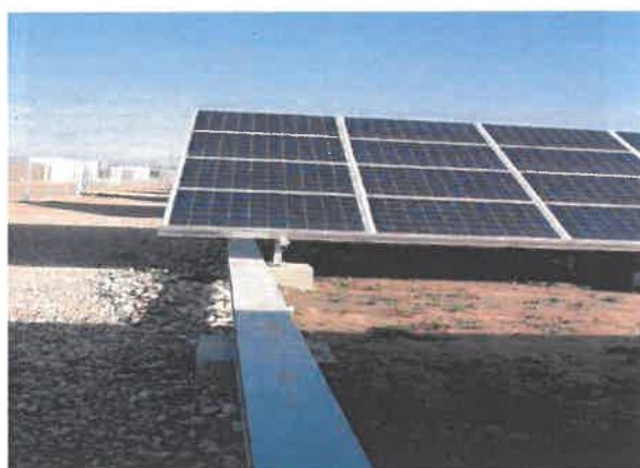
Figure 27 : Exemple d'un chemin de câbles
