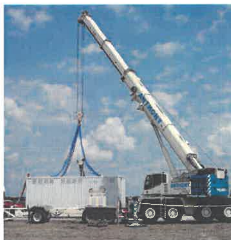
Figure 32 : Engin de levage utilisé pour la pose des postes onduleurs
