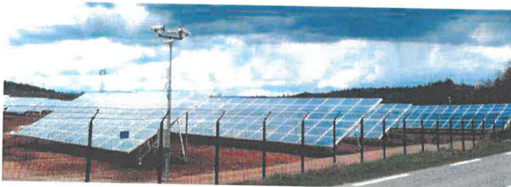
Figure 30 : Exemple de clôture et système de surveillance par caméras
