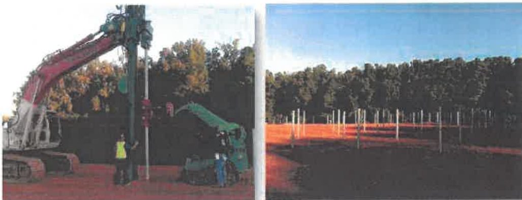
Figure 20 : Photographies d'installations de pieux battus
