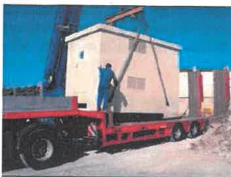
Figure 33 : Déchargement d'un poste électrique
