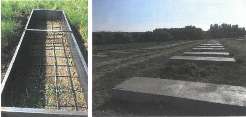
Figure 19 : Photographie de mise en place de longrine – source : ENGIE
