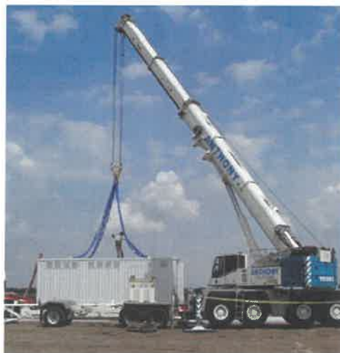
Figure 31 : Engin utilisé pour la pose des postes onduleurs
