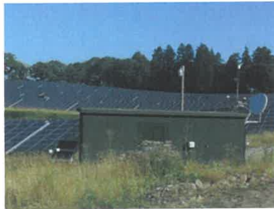
Figure 24 : Exemple de poste de livraison
