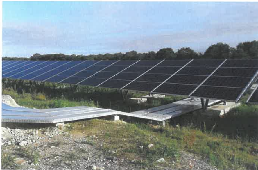
Figure 30: Exemple de chemin de câbles
