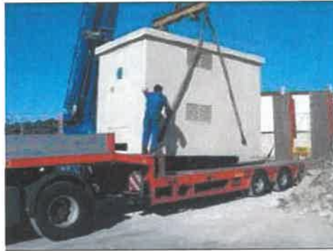
Figure 32 : Déchargement d'un poste électrique
