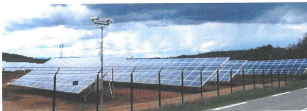
Figure 29 : Exemple de clôture et système de surveillance par caméras
