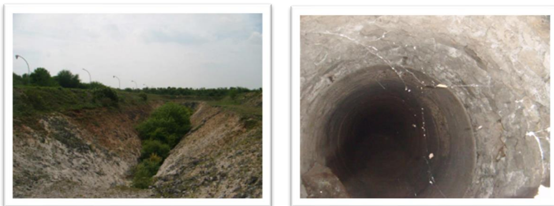
Photo 1 : Vue sur le bassin d'infiltration (à gauche) et le puits d'infiltration (à droite) du secteur Poulmic (Source : ETI Environnement et Technologies)
