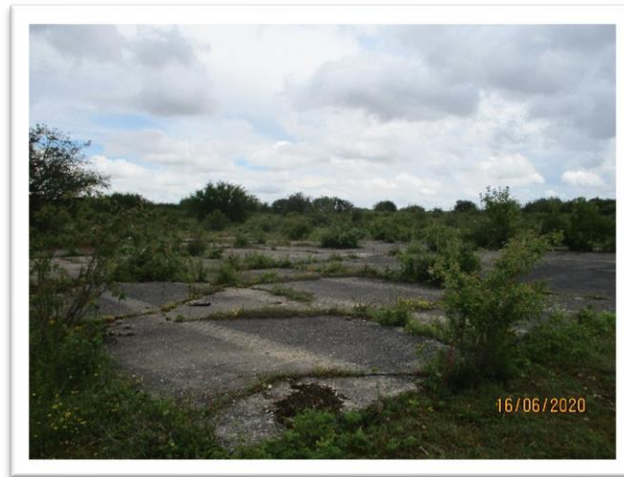
Photo 7 : Vue sur une ancienne plateforme en enrobé au sud du site
