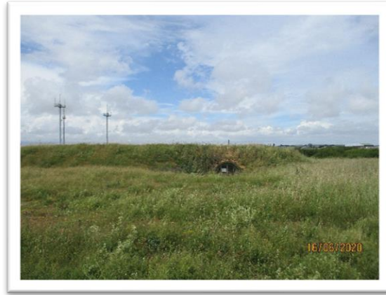
Photo 5 : Vues sur un abri de protection
