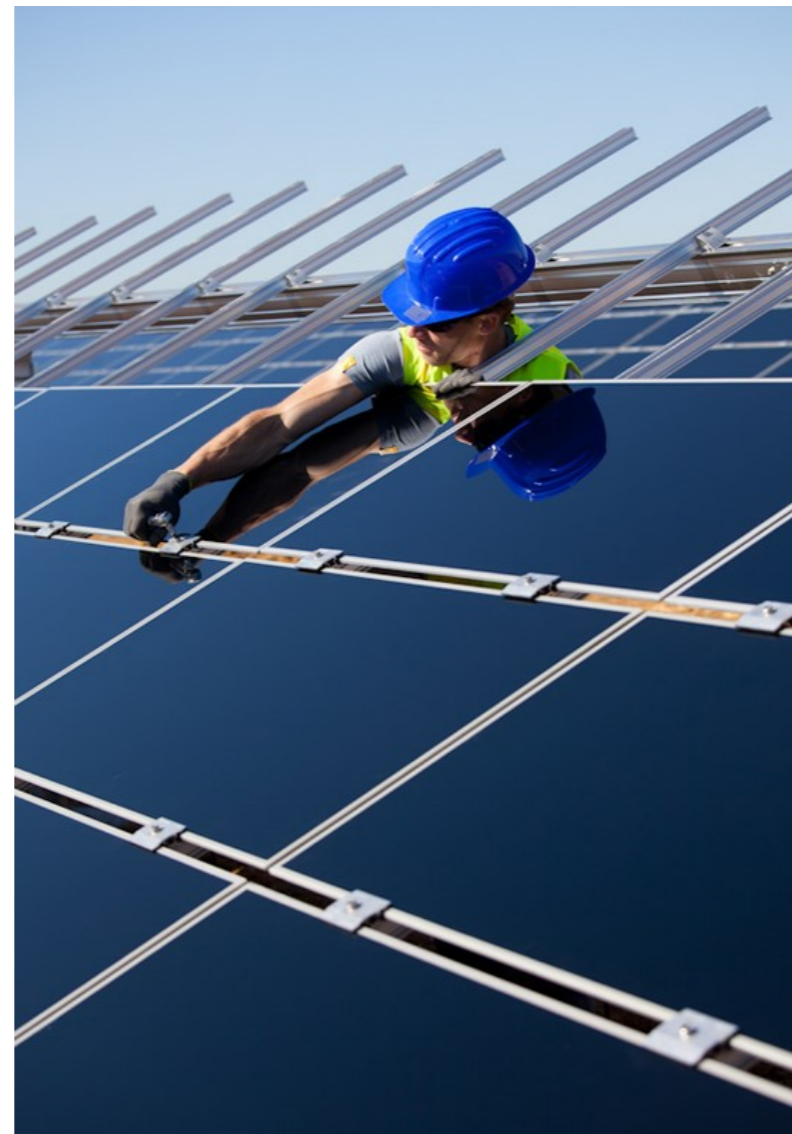
Remplacement de module (crédit photo EDF Renouvelables)
