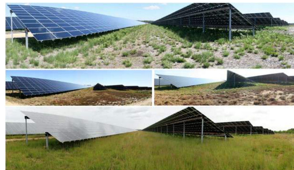
Figure 12 : Illustration du développement de la végétation sur un parc photovoltaïque d'EDF Renouvelables en 5 années Source : EDF Renouvelables
