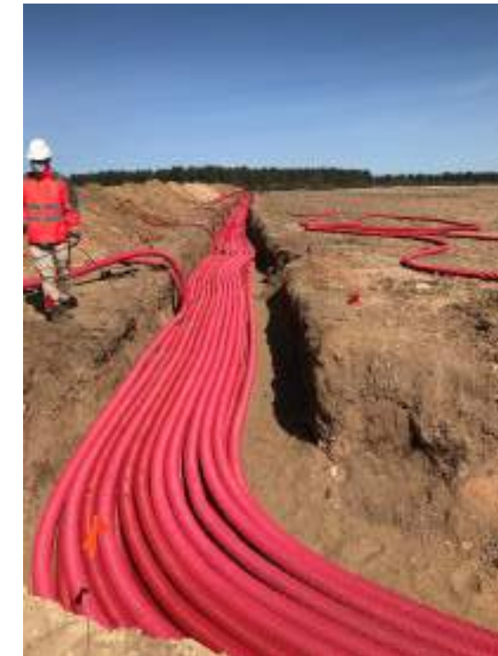
Figure 40 : Exemple de réalisation de tranchées du raccordement interne (Source : EDF Renouvelables)
