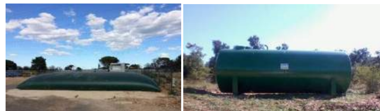
Figure 33 : Exemple d'une citerne souple et d'une citerne en dur (Source : EDF Renouvelables)
