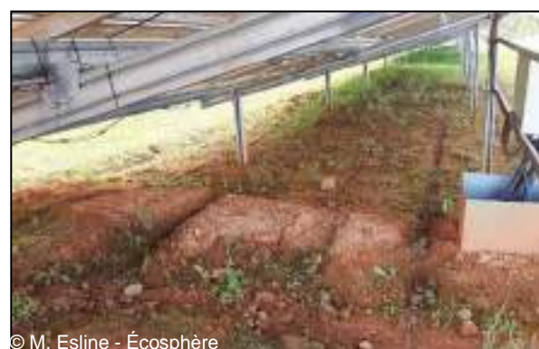
© M. Esline - Écosphère Figure 172 : Illustration de l'effet "splash" sous les rainures
