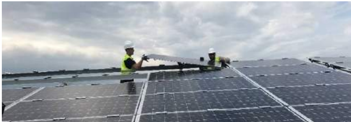
Figure 39 : Pose des modules (Source : EDF Renouvelables)
