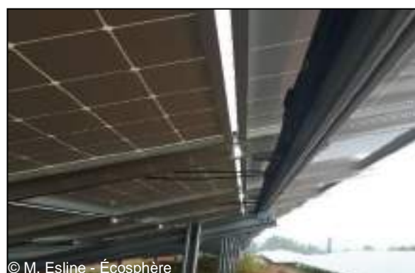
© M. Esline - Écosphère Figure 171 : Illustration des rainures permettant à l'eau de s'écouler
