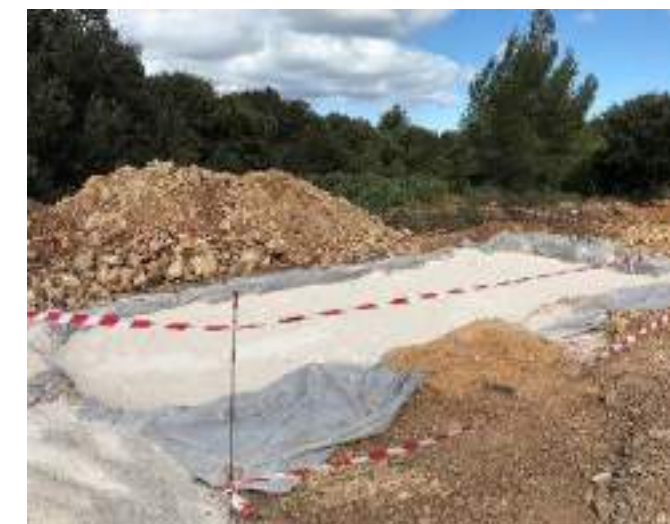
Figure 41 : Fouille préparée pour la pose d'un poste de conversion/transformation (Source : EDF Renouvelables)
