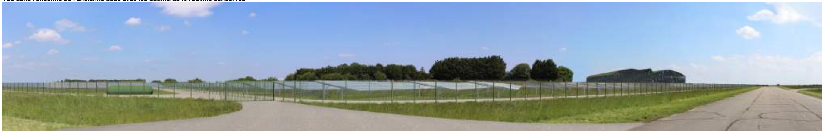
Vue sur les installations et le poste de livraison depuis la RD31
