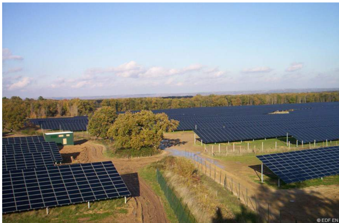
Figure 13 : Fauche différenciée sur la centrale solaire de Narbonne (11) (photo du haut) et corridor écologique préservé en fin de chantier au sein de la centrale de Bouloc (31) (photo du bas) Source : EDF Renouvelables
