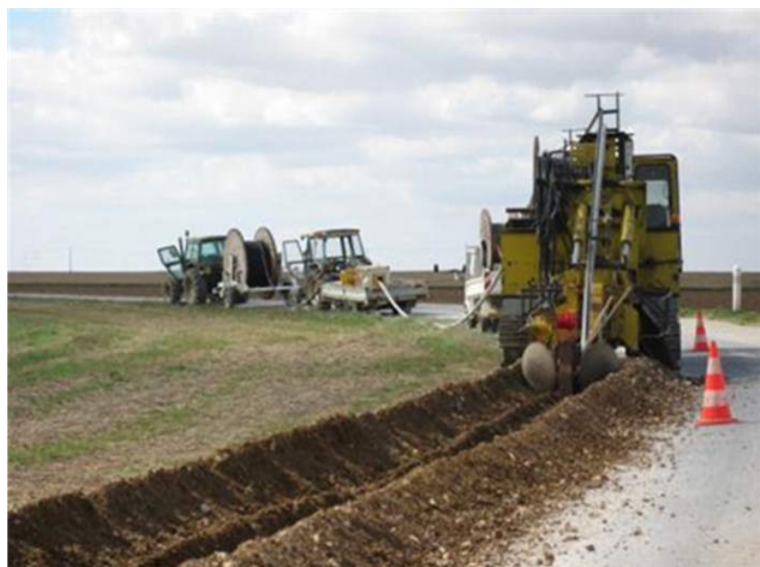
Figure 42 : Réalisation de tranchées du raccordement externe dans l'emprise des voies existantes (Source : EDF Renouvelables)
