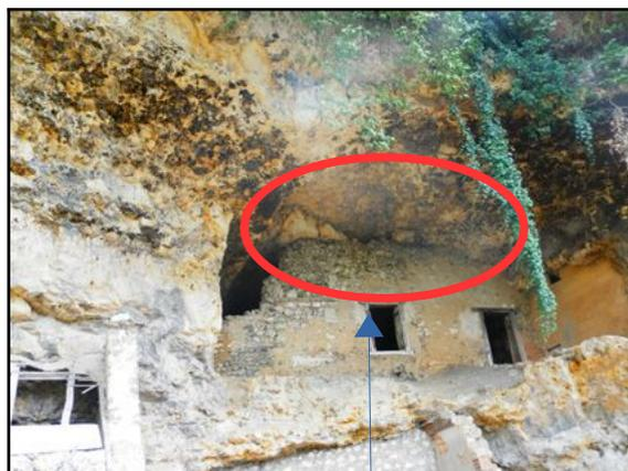
Figure 45: Blocs en équilibre au niveau du mur de la maison troglodyte
