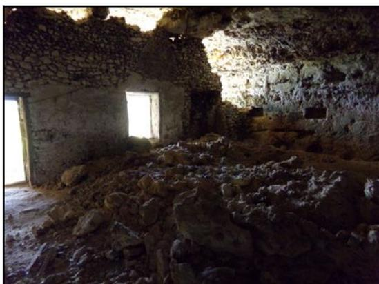
Figure 47: Chute de toit à l'intérieur de la cavité
