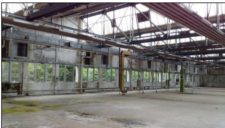
Figure 8 : Photographies du site en friche de la Messesselle (source : CC du Perche)
