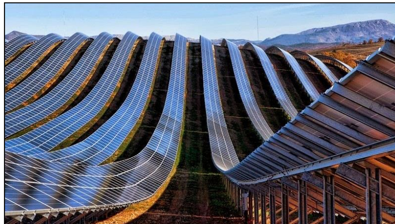
Figure 3 : Photographie de la centrale photovoltaïque des Mées dans les Alpes-de-Haute-Provence
