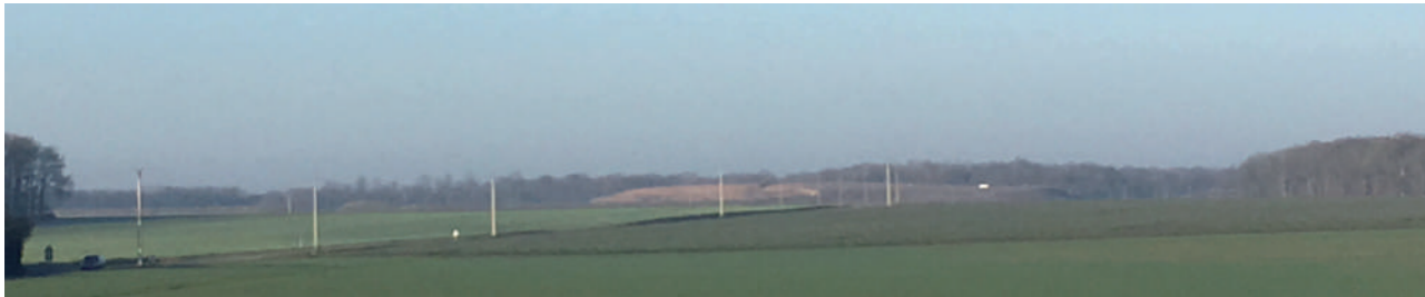
Le site d'enfouissement «La Mare Franc-jeu» repérable de loin du fait de sa teinte claire très contrastante avec l'horizon boisé... C'est ce signal dans le paysage qui permet d'identifier le site d'étude (juste derrière) depuis des zones éloignées.
