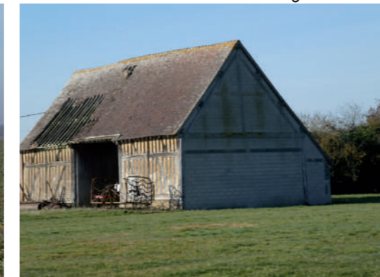
Bâtiment d'exploitation au Béchét
