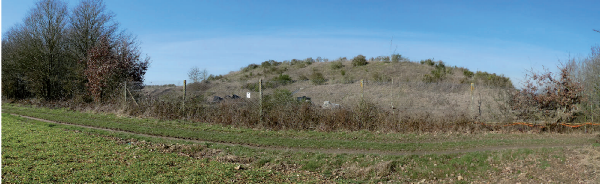
2 Percée visuelle sud-est depuis champ voisin
