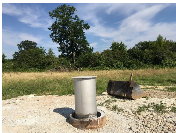
c) Vue du forage F2 en cours d'équipement (l'Eure coule au niveau des arbres visibles au fond)
