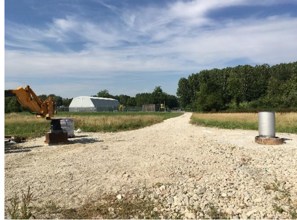
b) Vue depuis les forages vers le sud-ouest et le gymnase (le F1 est à gauche et le F2 à droite)
