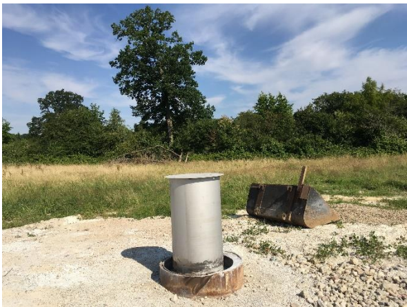
c) Vue du forage F2 en cours d'équipement (l'Eure coule au niveau des arbres visibles au fond)
