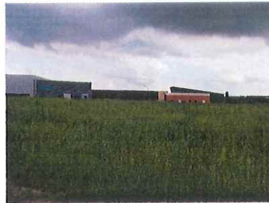
vue arrière du Drive Leclerc
