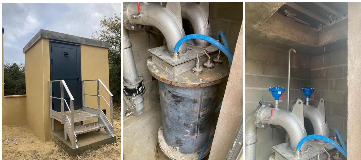
Local technique et tête du forage F2
