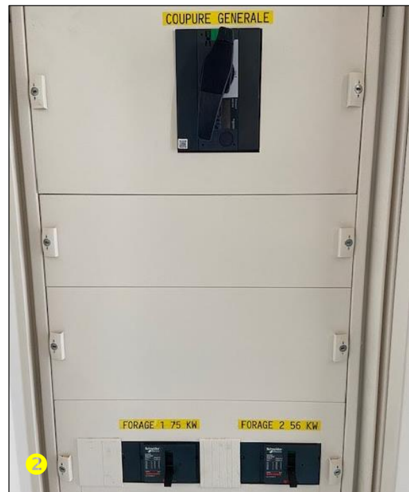
Figures 11 – Débitmètre électromagnétique SIEMENS SITRANS F M MAG 5100 w ❶ et Armoire électrique FB 105007 ❷ installés dans le local technique de pompage du Forage F2 (Photographie : Monsieur Eric MAISONS – Juin-21)
