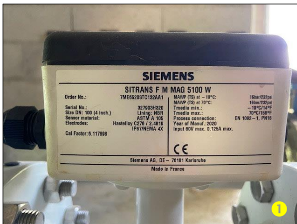
Figures 11 – Débitmètre électromagnétique SIEMENS SITRANS F M MAG 5100 w ❶ et Armoire électrique FB 105007 ❷ installés dans le local technique de pompage du Forage F2 (Photographie : Monsieur Eric MAISONS – Juin-21)
