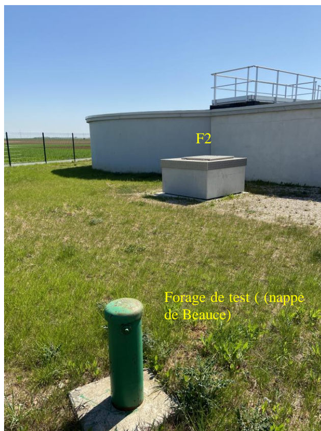
Figure 21. Forage de test
