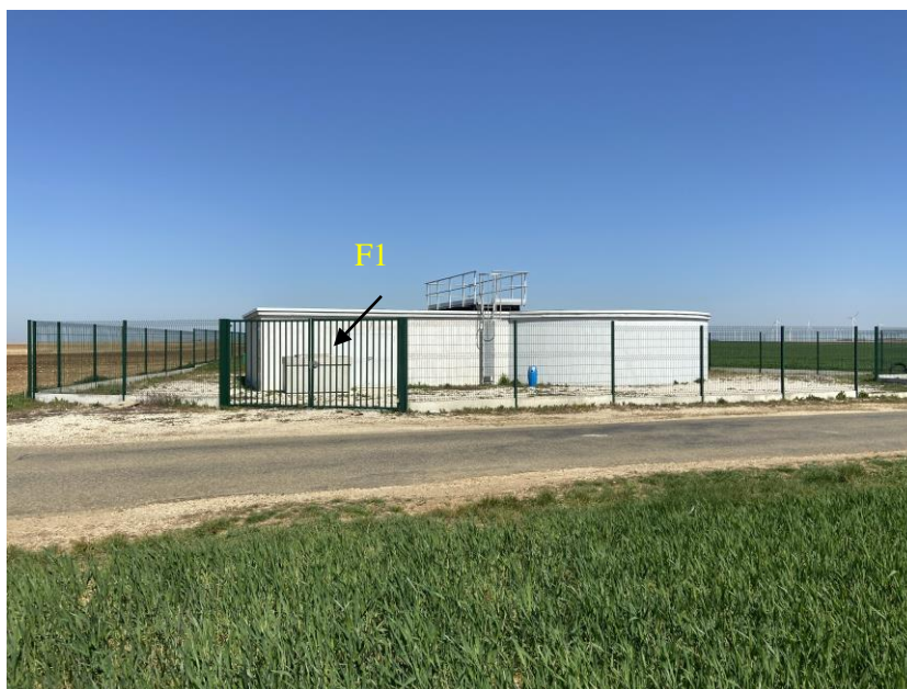
Figure 23. Portail du périmètre de protection immédiate
