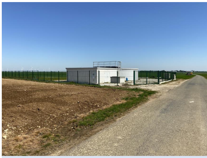
Figure 6. Vue des installations et du périmètre immédiat depuis le Sud-Ouest
