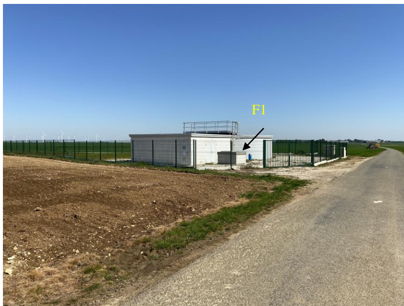
Figure 22. Grillage du périmètre de protection immédiate
