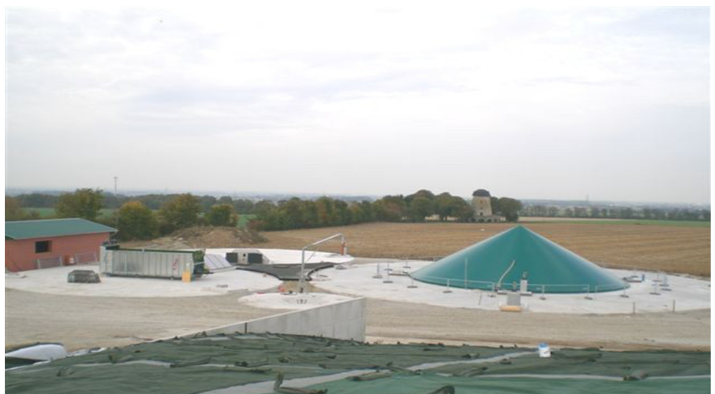
Installation de méthanisation agricole avec système « tank in tank » (post digesteur imbriqué dans le digesteur) enterré. Source : Biogas Hochreiter GmbH - A.E.B. - Méthafrance.
