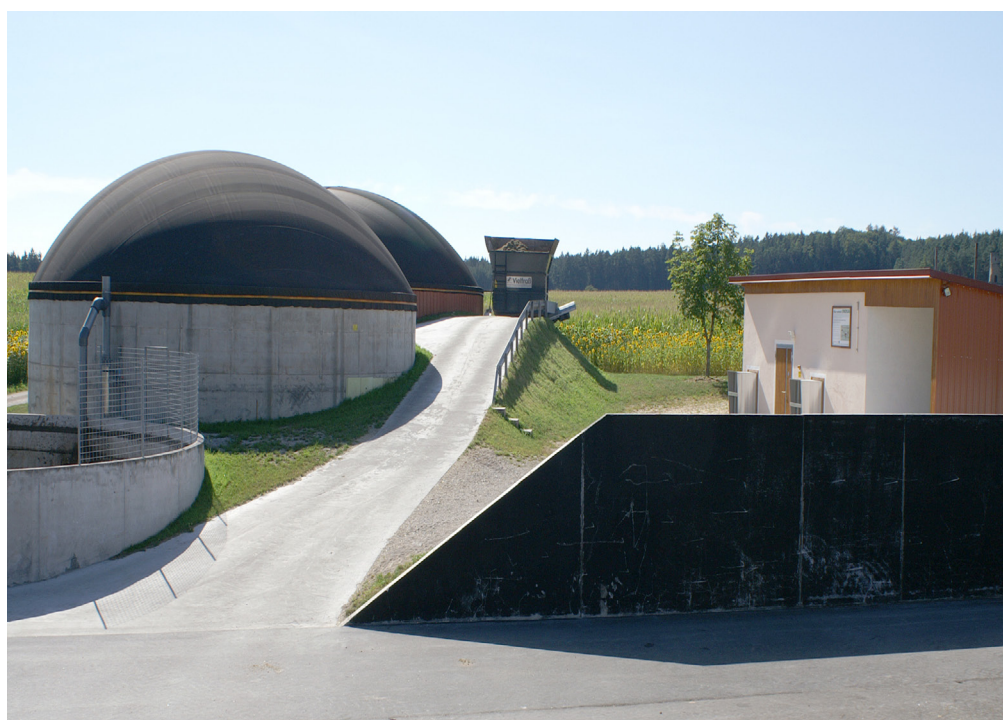
Installation de méthanisation agricole. Source agriKomp.
