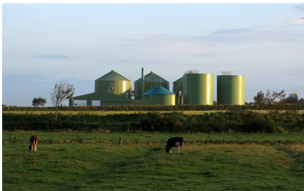
Installation de méthanisation à la ferme à Lohe-Rickelshof, Land du Holstein, Allemagne, photo par Dirk Ingo Franke, 2009 (CC)
