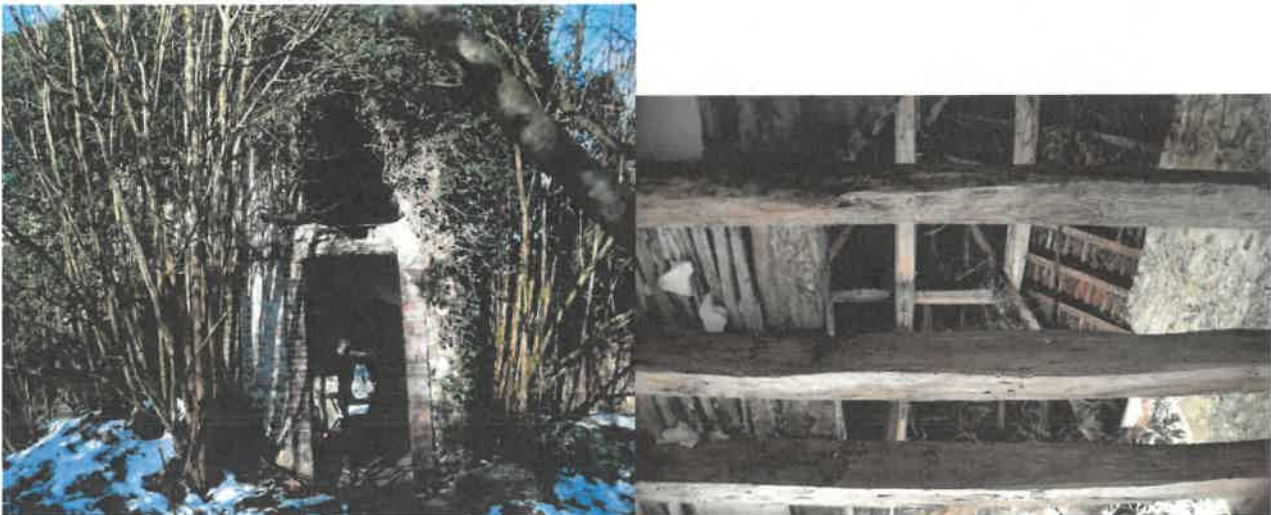
Photo : la petite maison des vergers et sa charpente.
