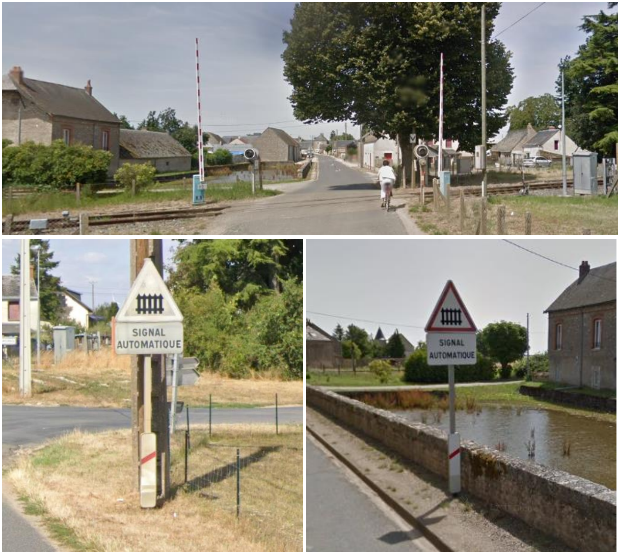
Photographie 28 : Signalisations du passage à niveau, à Gommiers (Source : Google Street View)
