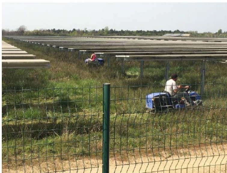
Entretien mécanique des centrales photovoltaïques d'Urbasolar
