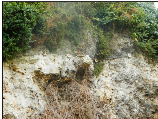
Figure 12: Filet plaqué à l'aplomb de la falaise
