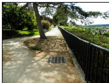
Figure 32: Collecteur d'eau pluviale à l'amont de la zone du glissement de terrain
