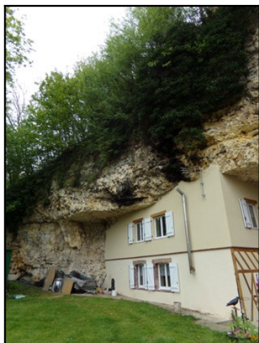
Figure 49: Maison troglodyte à l'entrée de la cavité
