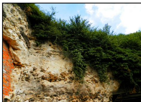
Figure 20: Filet plaqué sur le haut de la falaise
