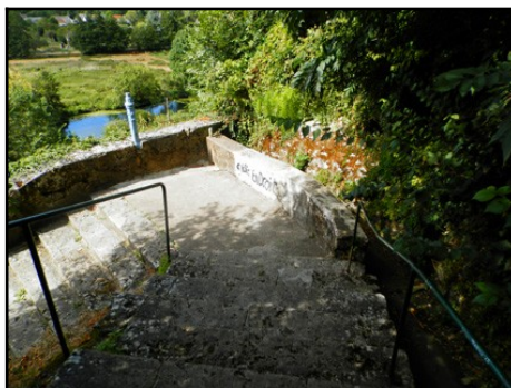
Figure 42: Rejet d'eau pluvial dans le talus
