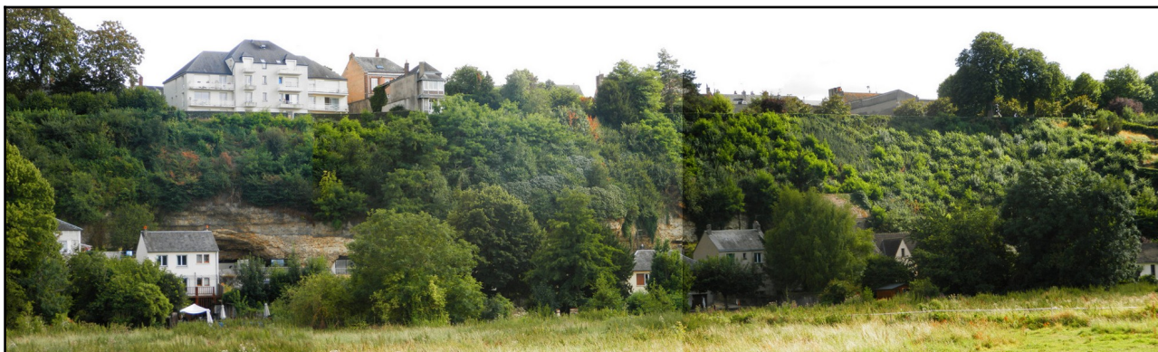
Figure 5: Vue d'une partie de la falaise depuis le chemin de la Belle-Arrivée - source : Alp'Géorisques
