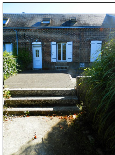
Figure 53: Bâtiment au n°5, rue du Mail
