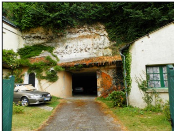
Figure 2: Cavité souterraine utilisée comme garage au 25 rue des Fouleries - source : Alp'Géorisques
