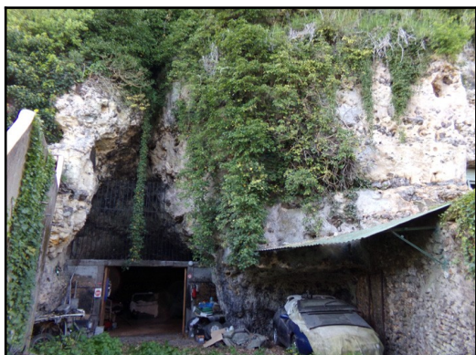
Figure 8: Partie est de la falaise sur ce secteur
