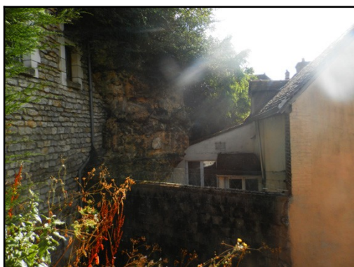
Figure 25: arrière du bâtiment qui donne sur la rue des Fouleries
