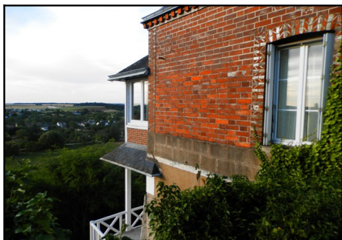
Figure 54: Partie du bâtiment construite dans la pente
