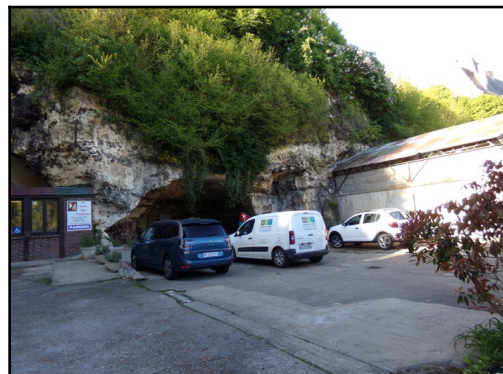
Figure 10: Vue de la falaise au-dessus de la Cave des Fouleries
