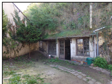
Figure 23: Vue sur la falaise et l'entrée de la cavité à l'arrière du bâtiment
