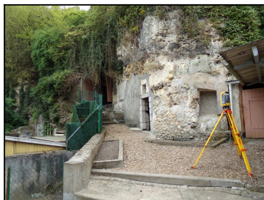
Figure 7: Partie ouest de la falaise sur ce secteur et entrée des cavités
