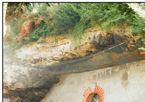
Figure 11: Filet de protection à l'entrée de la Cave des Fouleries
