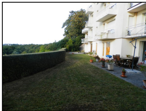
Figure 52: Vue de l'arrière de l'immeuble du 28, rue Jean-Moulin
