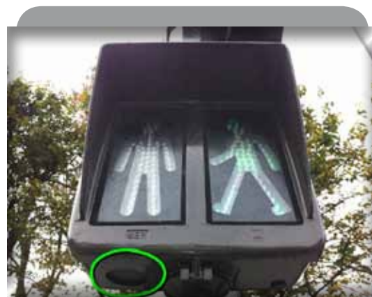
« Signal R12 » équipé d'un répéteur sonore
