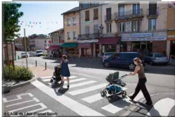
Les abaissés garantissent un confort d'usage pour tous
