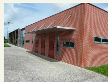
Centre des examens du Permis de conduire de Mainvilliers
