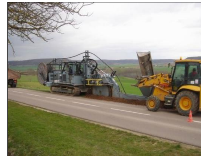
Réalisation d'une tranchée
