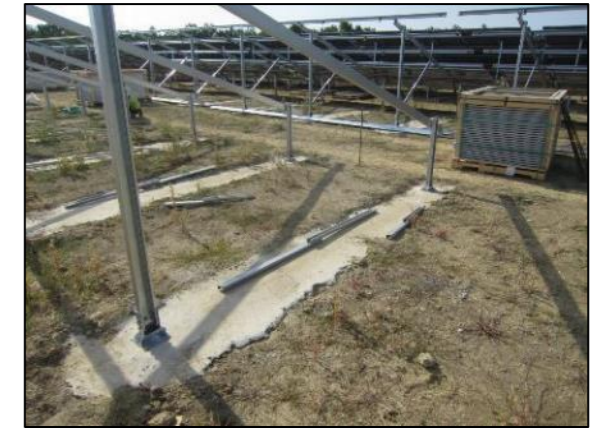
Exemples de longrines béton
