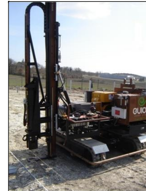
Engin de battage de pieux
