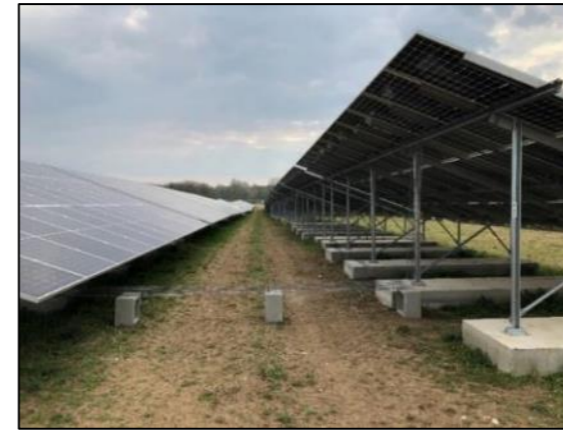
Exemples de longrines béton
