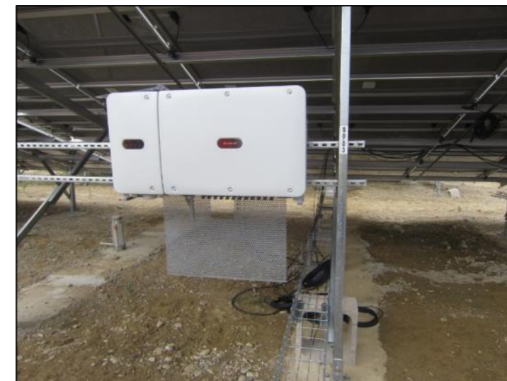
Exemple d'onduleur décentralisé
