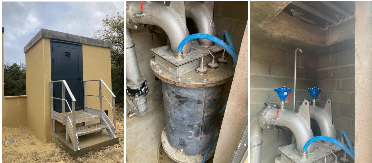
Local technique et tête du forage F2
