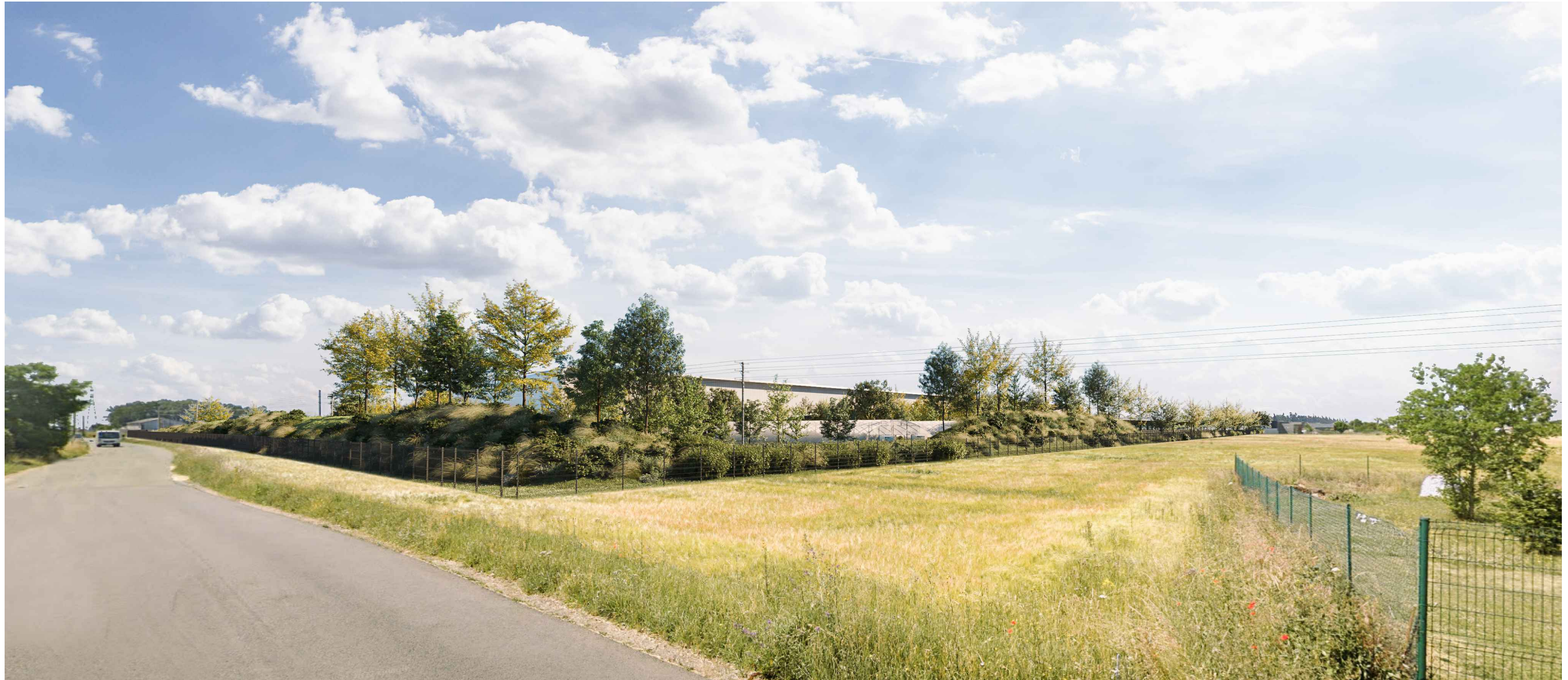
1 - VUE DEPUIS LE CHEMIN DE BLAINVILLE
