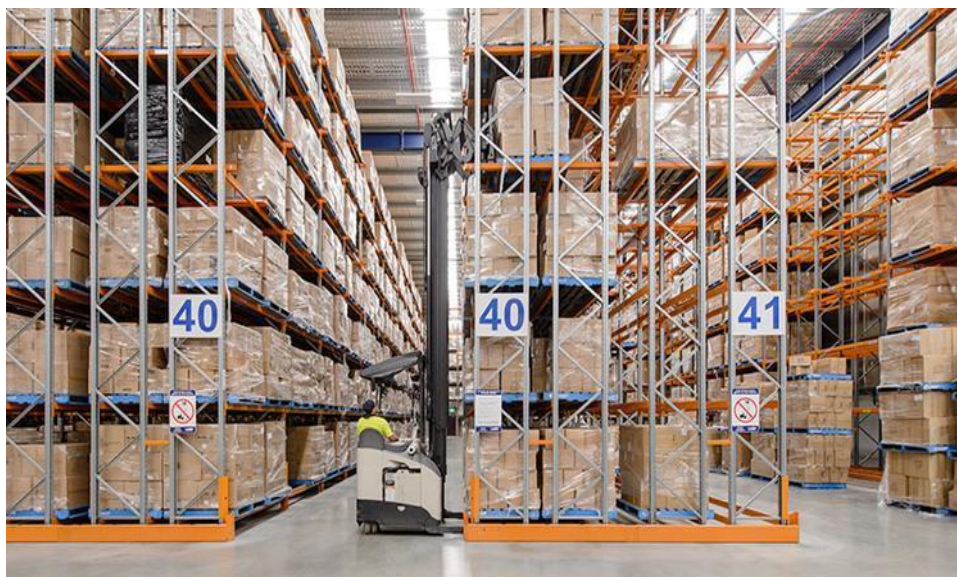
Figure 8 : Entreposage de type Double deep
