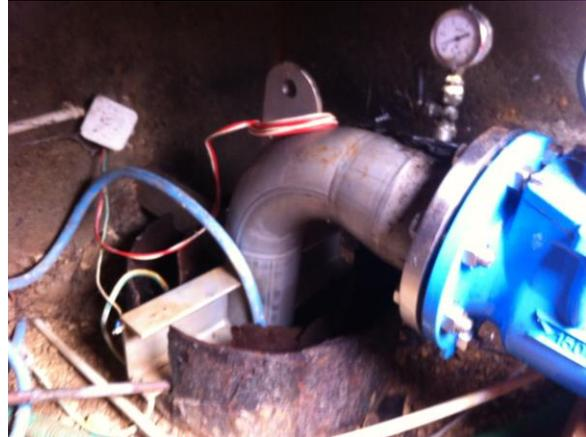
b) Tête de forage et canalisation sous la dalle de protection
