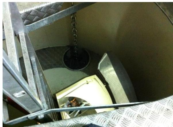
b) Vue du bac de rétention à l'intérieur de l'éolienne
