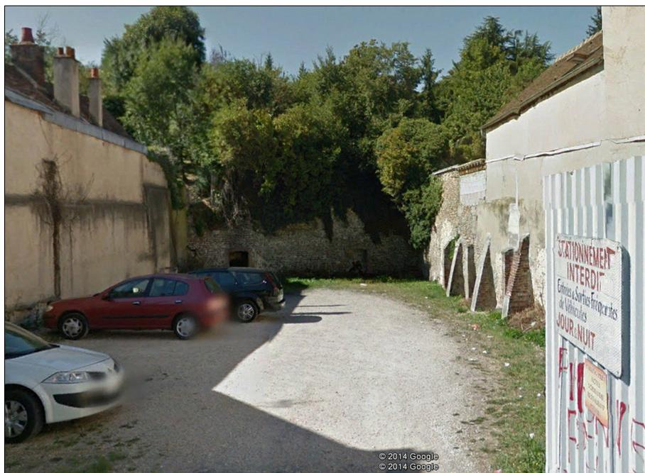
Figure 19: Exemple d'escarpement muré à l'Ouest de la rue du Vieux Pavé. Noter les entrées de cavités dans le mur de pierres au fond de la cour.
