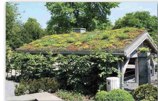
Figure 64 / Toiture végétalisée à 2 pans sous un climat océanique, Grugapark près d'Essen en Allemagne.
