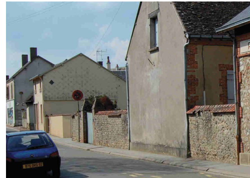
mur de moellons (avant de parcelle)
