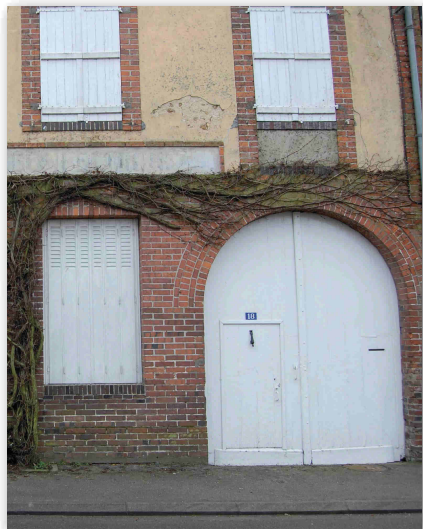
Figure 76 / La porte de garage et la fenêtre au dessus reprennent le même axe ce qui produit une excellente intégration à la composition de la façade.
