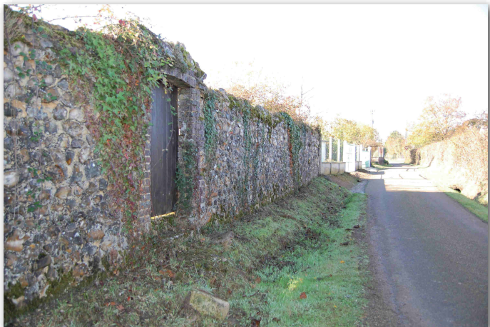
Figure 80 / Mur haut de moellons à silex, isolant l'arrière des jardins du domaine public.
