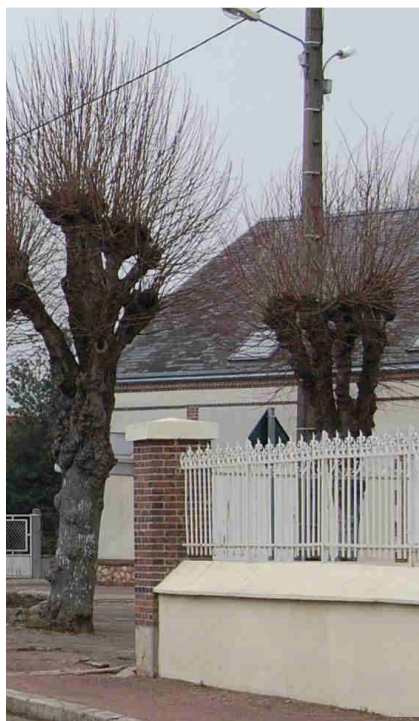
Figure 31 / À gauche, clôture en mur bahut traditionnel avec couronnement, surmonté d'une grille en fer forgé, place de la mairie.
