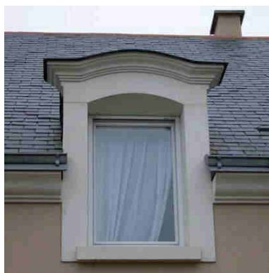
Figure 10 / Lucarne type «chapeau de gendarme» ou «en guitare».
