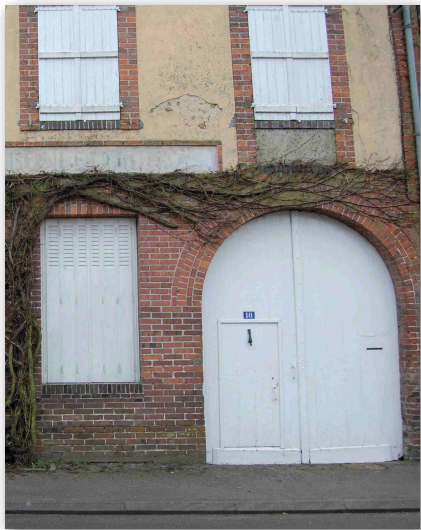
Figure 47 / La porte de garage et la fenêtre au dessus reprennent le même axe ce qui produit une excellente intégration à la composition de la façade.
