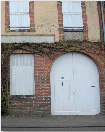
Figure 9 / La porte de garage et la fenêtre au dessus reprennent le même axe ce qui produit une excellente intégration à la composition de la façade.
