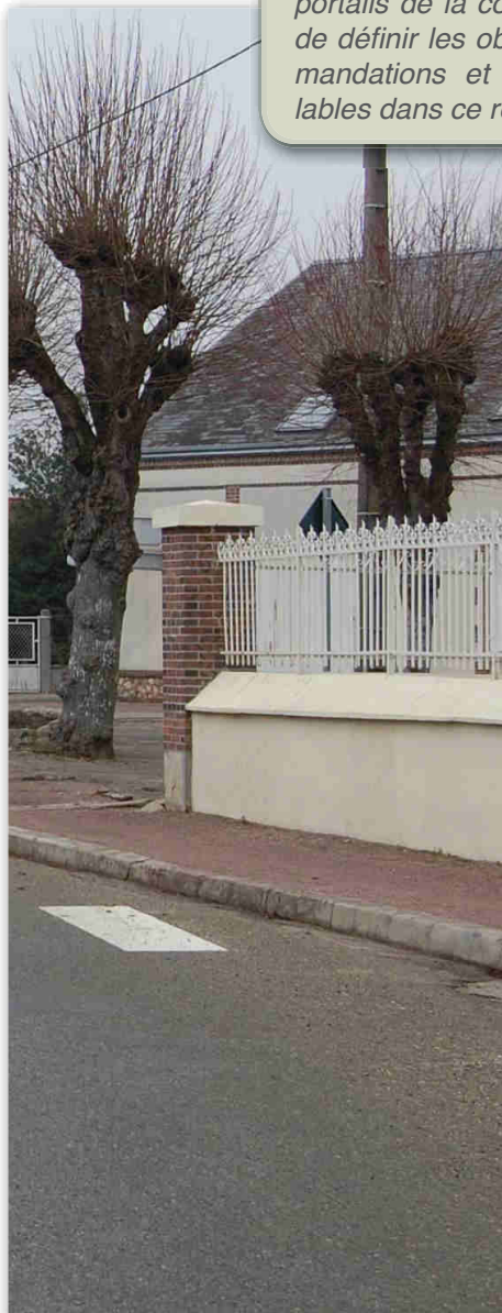
Figure 40 / À gauche, clôture en mur bahut traditionnel avec un couronnement, surmonté d'une grille en fer forgé, place de la mairie.
