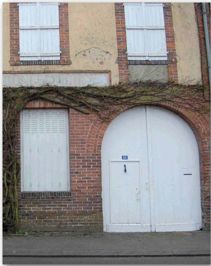
Figure 61 / La porte de garage et la fenêtre au dessus reprennent le même axe ce qui produit une excellente intégration à la composition de la façade.
