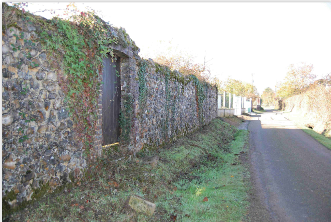
Figure 65 / Mur haut de moellons à silex, isolant l'arrière des jardins du domaine public.
