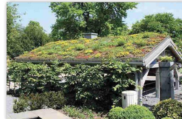
Figure 50 / Toiture végétalisée à 2 pans sous un climat océanique, Grugapark près d'Essen en Allemagne.
