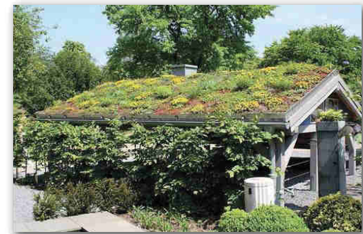
Figure 12 / Toiture végétalisée à 2 pans sous un climat océanique, Grugapark près d'Essen en Allemagne.
