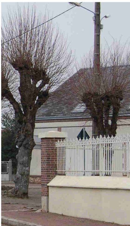
Figure 13 / À gauche, clôture en mur bahut traditionnel avec couronnement, surmonté d'une grille en fer forgé, place de la mairie.
