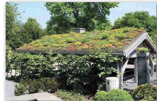
Figure 79 / Toiture végétalisée à 2 pans sous un climat océanique, Grugapark près d'Essen en Allemagne.
