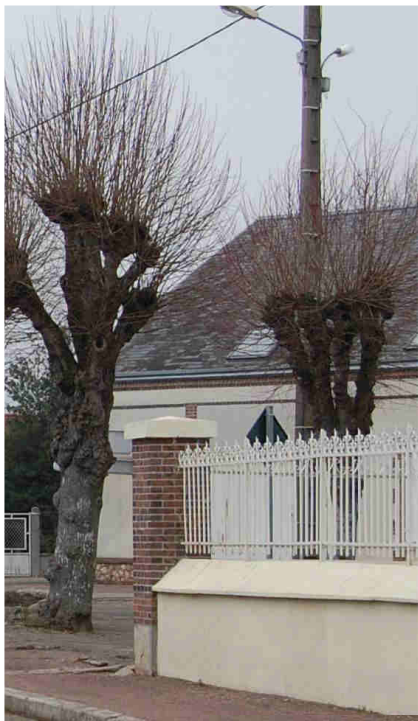
Figure 51 / À gauche, clôture en mur bahut traditionnel avec un couronnement, surmonté d'une grille en fer forgé, place de la mairie.
