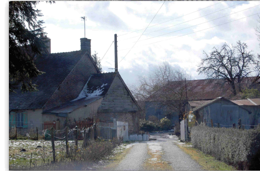
Figure 63 / Traditionnellement, les faîtages des annexes se situent dans le prolongement des faîtages du bâtiment principal et les pentes des bâtiments principaux varient autour de 50°.
